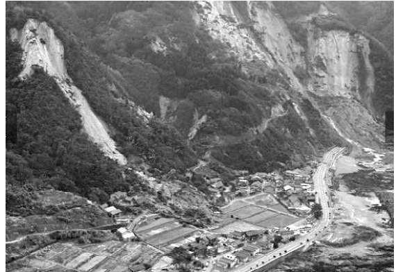
土砂崩れで多くの集落が孤立した(1/3珠洲市仁江町・朝日新聞社)
