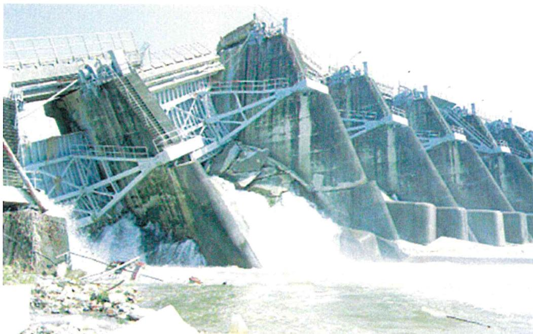
(下は、1999年の集集地震（台湾）において、断層のずれで破壊された石岡ダムの様子)
