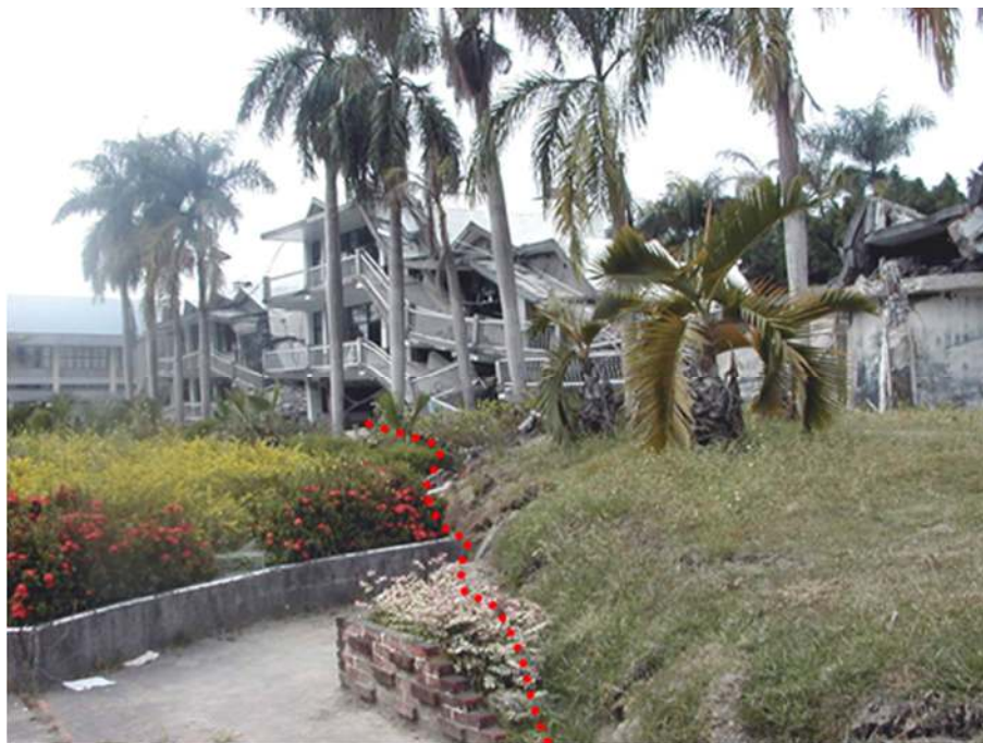
（台湾中部地震の際に断層線上にあったために倒壊した建物）
